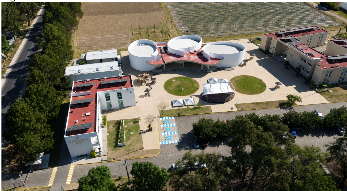
Figura 3. Vista aérea de la infraestructura del CUCBA.
